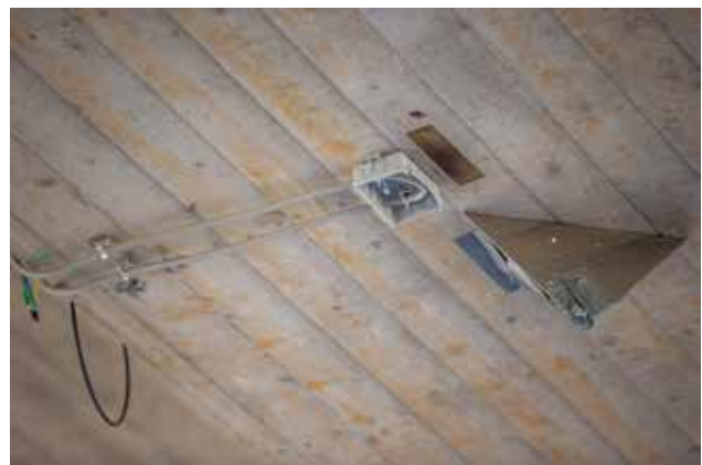
2 Vorbereitete Messstelle für Betondehnungstreifen sowie Radarreflektor zur präzisen GBR-Messung © Büro für Strukturmechanik
